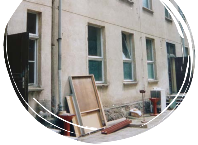
Neubrandenburg 1997: Umbaumaßnahmen vor dem Einzug der Schule ▲
